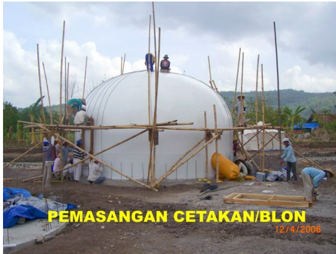
Gambar 2.2 Pemasangan cetakan dengan menggunakan balon
