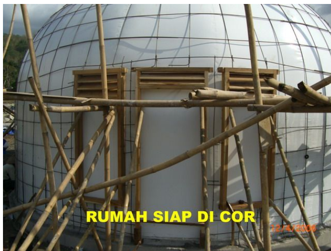
Gambar 2.3 Pemasangan kerangka bangunan
