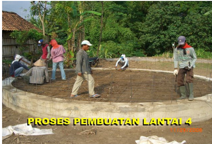
Gambar 2.1 Proses pembuatan lantai tahap 4
