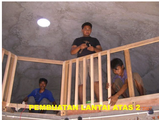
Gambar 2.6 Proses Pembuatan Lantai dua
