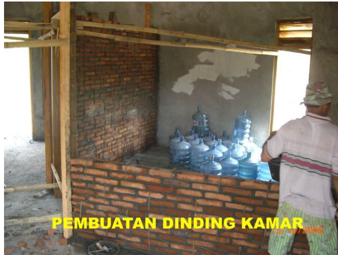
Gambar 2.5 Proses Pembuatan sekat kamar
