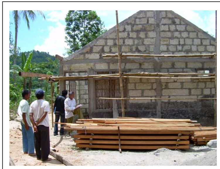
Gambar 4.17. Pembangunan kembali rumah yang roboh akibat bencana gempa bumi dengan menggunakan Batu Alam Lokal Kabupaten Gunungkidul
