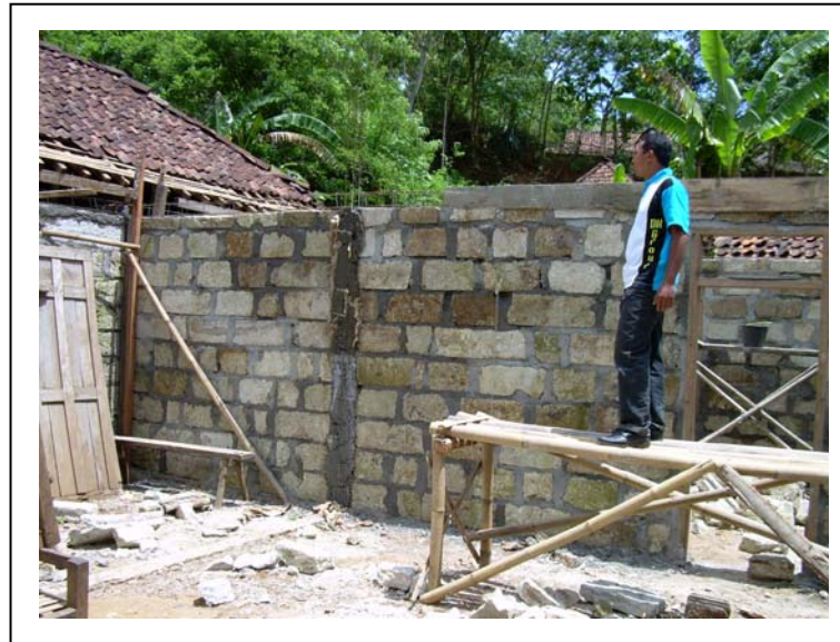
Gambar 4.16. Penggunaan Batu Alam Lokal Kabupaten Gunungkidul untuk rehabilitasi rumah akibat bencana gempa.
