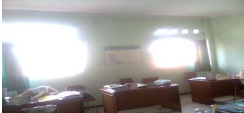
Gambar 3. Ruang Kesehatan Lingkungan sebelum penambahan kelambu
