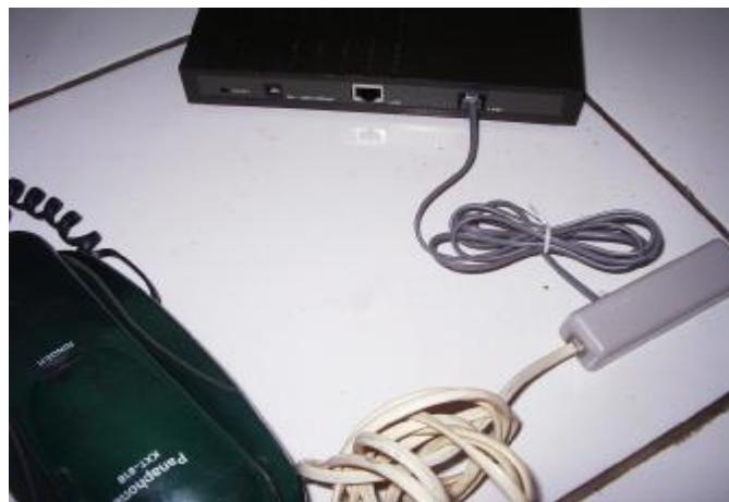
Gambar 4.3 Sambungan kabel modem dan splitter
