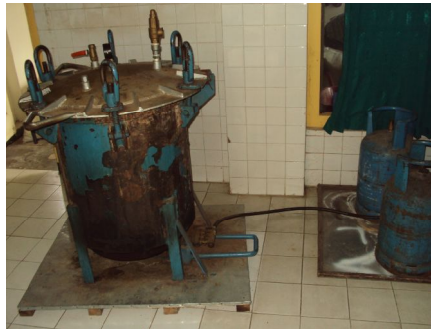
Gambar 4.8 Boiler yang digunakan dalam proses sterilisasi
