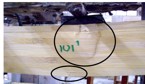
Gambar 5. Pola kerusakan balok tepat pada titik beban
