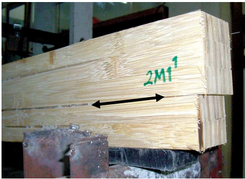
Gambar 6. Kerusakan sepanjang garis perekatan balok laminasi
